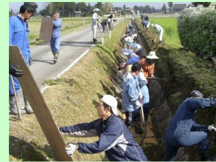
ヒメイワダレスウ植栽前の開水路路面整形
