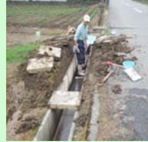
水路の目地コーティング作業
