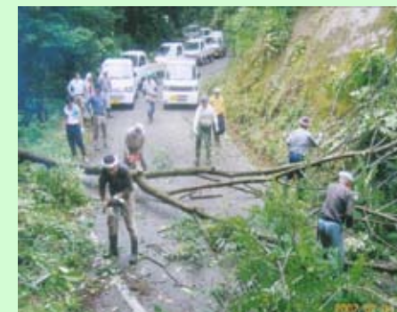
山間部農道の繁茂枝打ち作業
