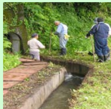
農業施設の点検・補修
