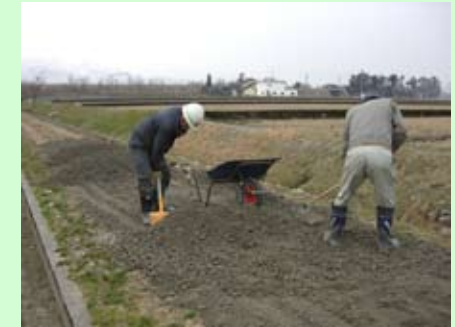
農道の補修作業
