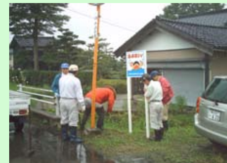
用水看板の設置
