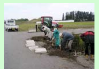
崩落部の張りブロック取り付け活動
