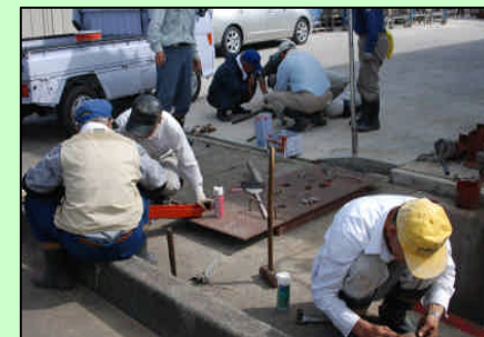
用排水路のゲート分解・手入れ
