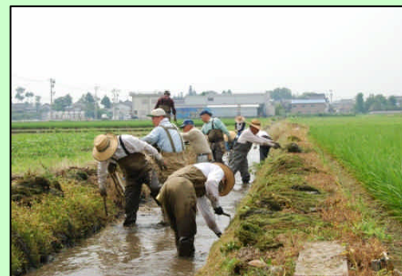
用排水路の草刈り・泥上げ
