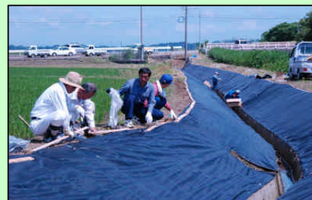
開水路法面への防草シート張り
