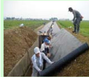
防草シート張り
