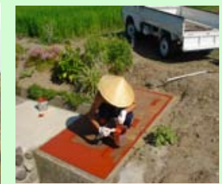
蓋版塗装補修
