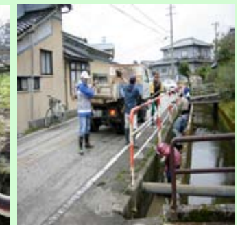
水路の泥上げ
