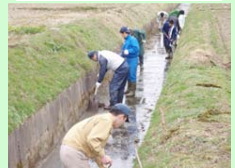
水路の土砂・雑草・藻等の除去
