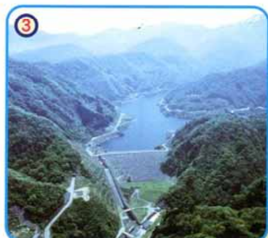
③ 白中ダム (ロックフィルダム)
