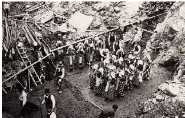
女人夫による搗き固め作業
