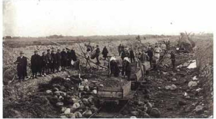
被災後の水路掘削状況（昭和9年11月）
