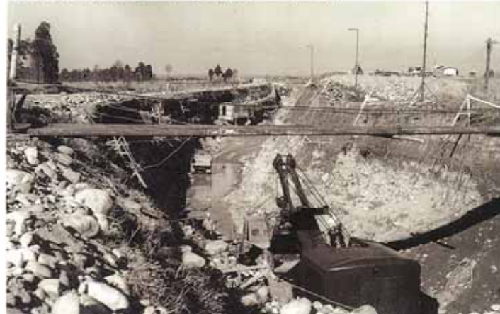
常西用水路県営事業工事現場（昭和37年10月）
