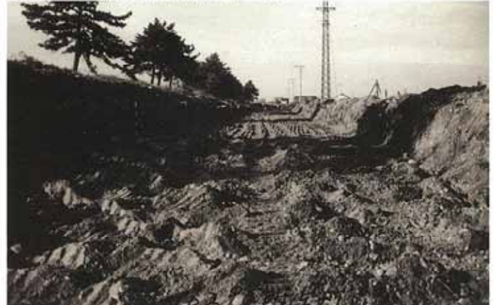
常西幹線水路掘削状況（昭和44年12月）
