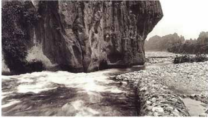
鷹泊取水口（合口後の取水口）
