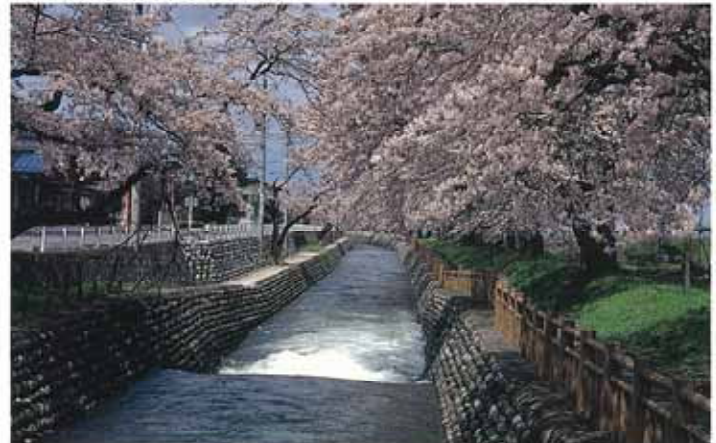
常西幹線水路（やすらぎ施設）
