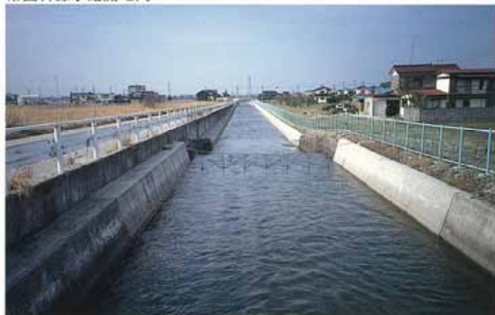
常西幹線水路開地内
