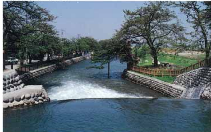
常西幹線水路上滝地内
