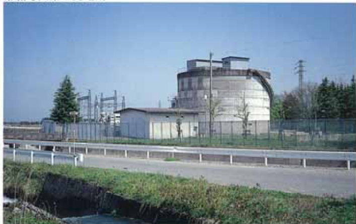
常願寺川第3発電所
